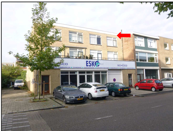
Figuur 2. Ruimte tussen muur en dakbeschot (rode pijl)
